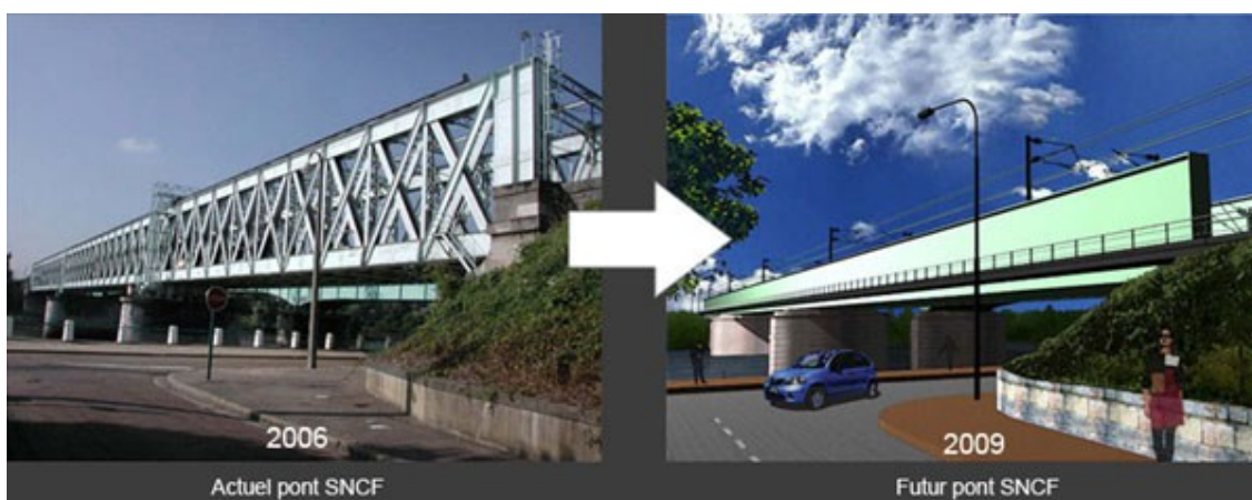
Figure 2 : Exemple de changement de pont métallique.
