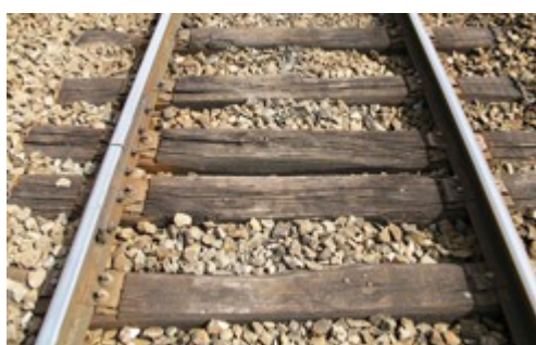
Rails courts sur traverses bois
