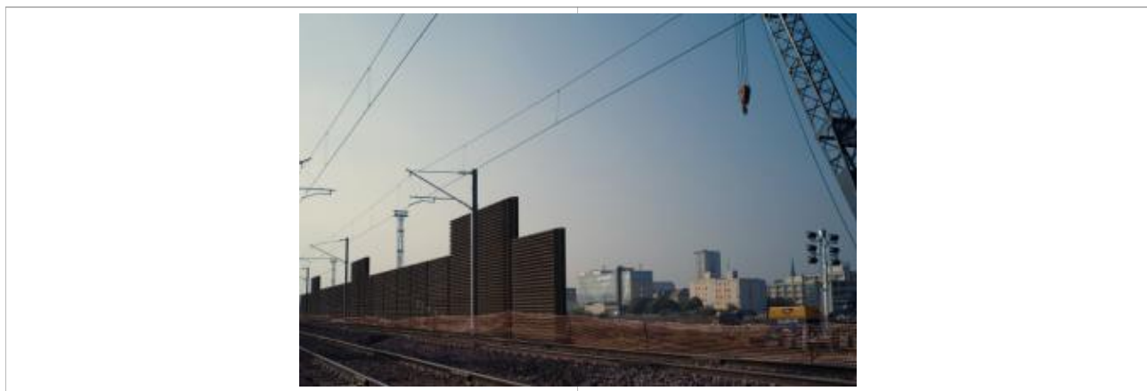
Figure 1 : écrans acoustiques à Metz.
